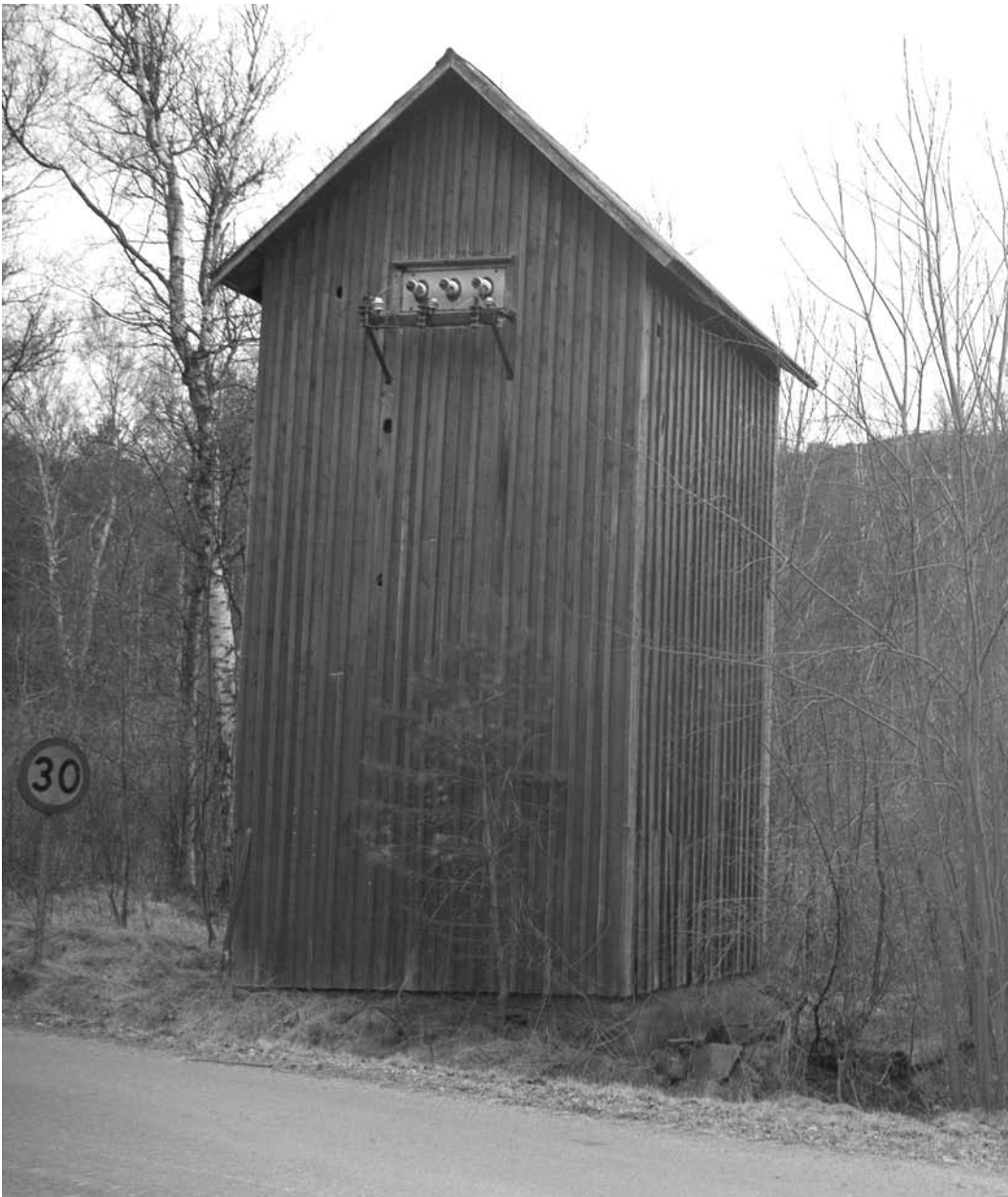
Ill. 28. Transformatorstation vid Lahälla. Den visar på stenindustrins betydelse för elektrifieringen av samhällena i Bohuslän. Stationen i sig är inte unik men dess plats i miljön, intill knottfabrik och stenbrott, är signifikant.
