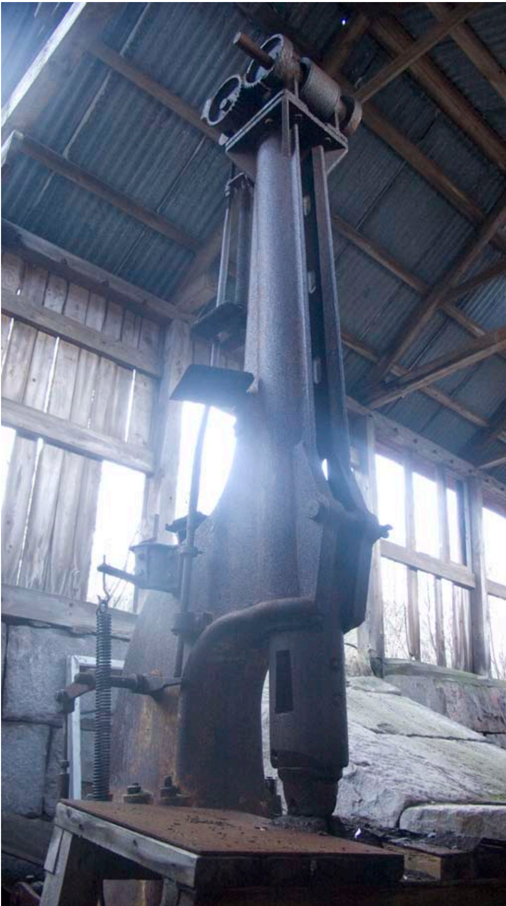
Ill. 20. Spaltmaskin i Lahälla, en fabriksmiljö bevarad i närmast ursprunglig utformning. I anslutning till fabriken finns även en transformatorstation, bostadsbarack, lastageplats och hamn. Ett givet inslag i ett kulturresevat. Idag åtnjuter fabriken inget skydd och skötsel saknas helt.
