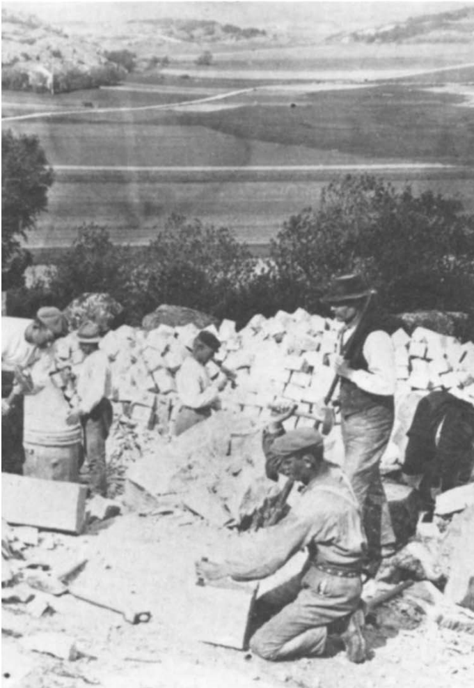
Ill. 9. Småbrott sydost om den gamla Åkeredsskolan omkring 1908. I småbrotten skedde alla arbetsmoment av en eller ett fåtal stenhuggare. Det vanligaste var att två eller tre delade på ett brott, eller tog upp var sitt brott intill varandra så att de kunde hjälpas åt med tyngre moment. Uttag av sten och bearbetning skedde på samma plats. Ett problem vid dessa brott var skrotstenen. Oftast fanns inte resurser att transportera undan den varför brotten fick överges innan den bearbetbara stenen tagit slut. Bild från Nässets hembygdsförenings arkiv..
