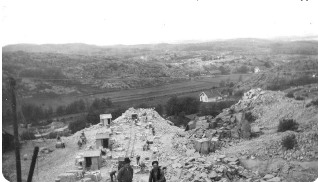
Ill. 8. Amdalsbrottet. I storbrottet var arbetsmomenten uppdelade på ett industriellt sätt. Uttag av råämnen skedde i storbrottet och transporterades sedan till bearbetningsplatsen, i detta fall med hjälp av vagnar på räls. Även skrotstenen kunde transporteras bort på detta sätt. På bearbetningsplanen fanns skjul för stenhuggarna där tillverkningen av slutprodukten skedde. Bild från Hamburgsunds bildarkiv.
