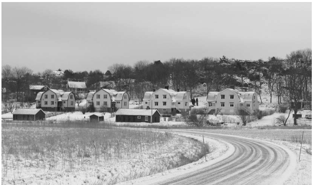
Ill. 10. Bolagshus vid Ed på Härnäset. På andra sidan berget bakom barackerna ligger Eds storbrott. Foto av Calle Fjällstål.
