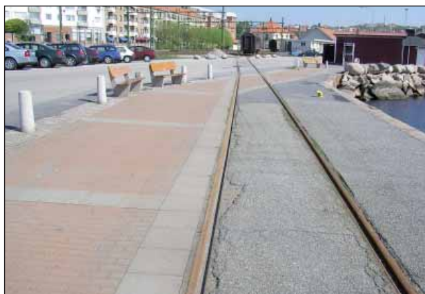
Strandpromenaden korsar järnvägsspåren på Anderssons kaj. Gångbanan är markerad med röd betongsten samt sittbänkar och pollare i granit.
