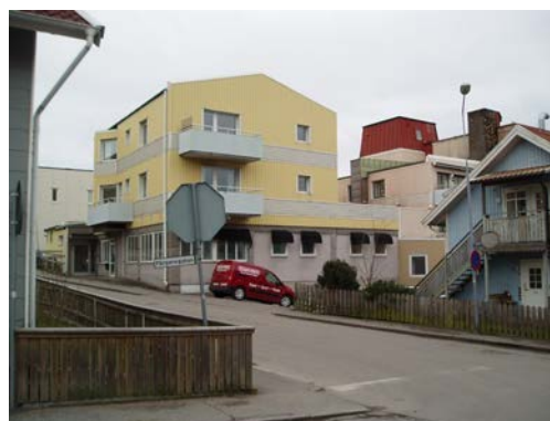
Bebyggelse inom Södra hamnen 6:2, sett från Färgaregatan nordöst om planområdet.
