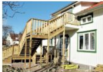
På baksidan av skolan, bygger man nu på med en extra ingång.
